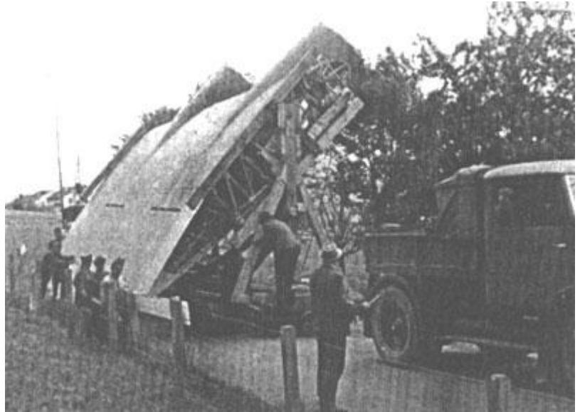
Auf einem Tieflader der SBB wird der Flügel nach Dübendorf transportiert. (305)
